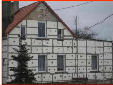
Fot. 11÷12 Przykłady nieprofesjonalnego wykonawstwa docieplenia
