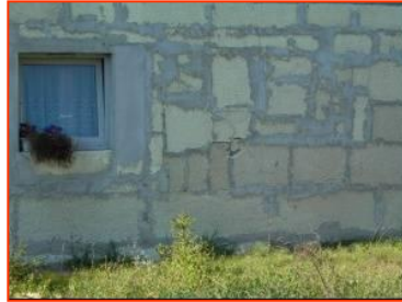
Fot. 11÷12 Przykłady nieprofesjonalnego wykonawstwa docieplenia
