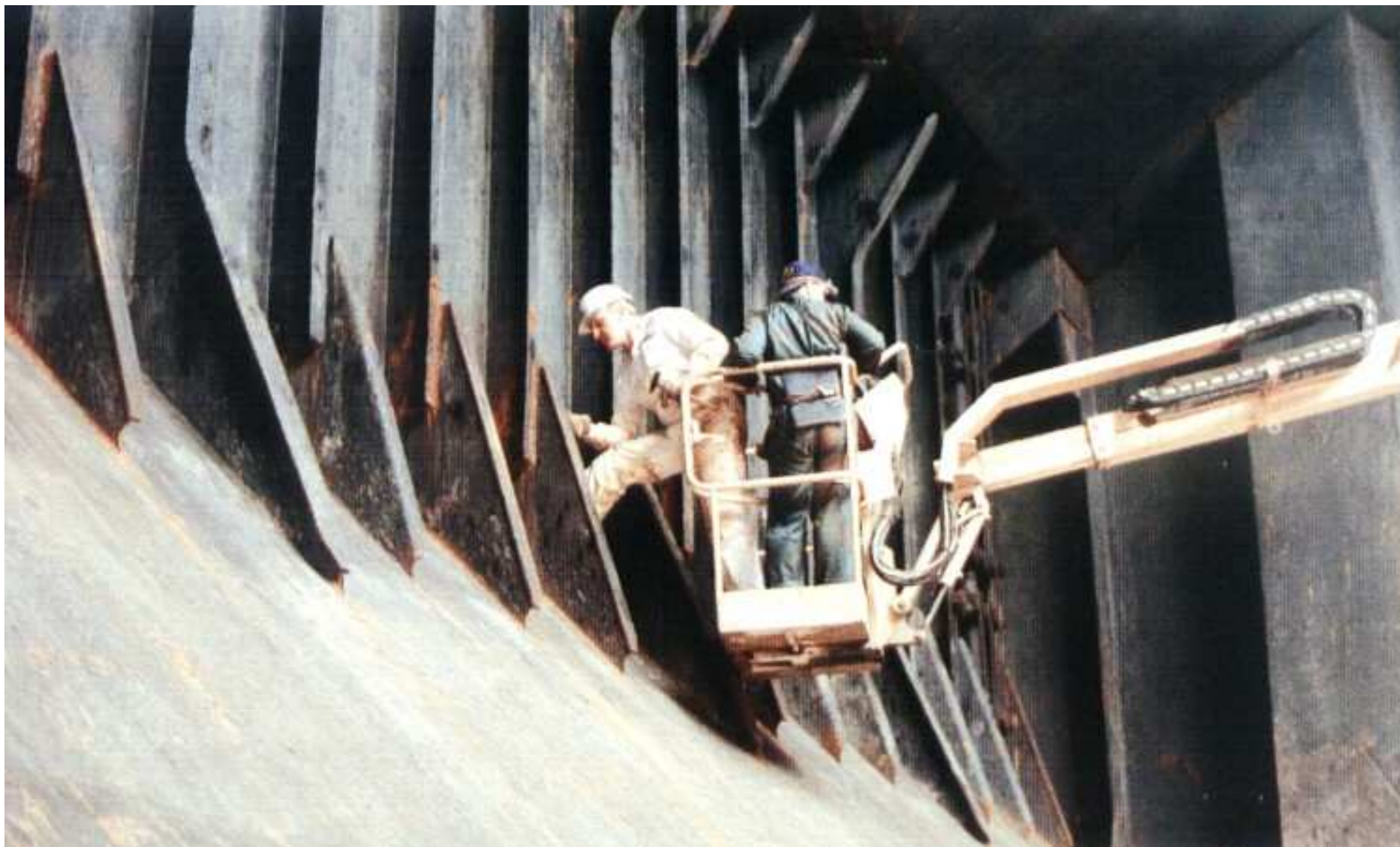
Kontrola i konserwacja poszycia ładowni
